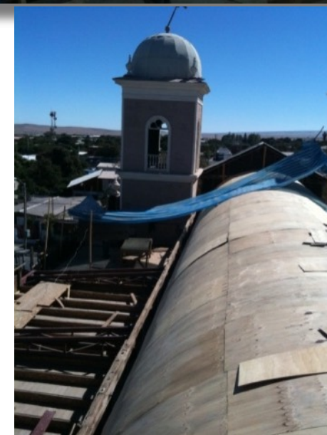
FOTOGRAFIAS PLACA TERCIADO 9mm EN OBRA
