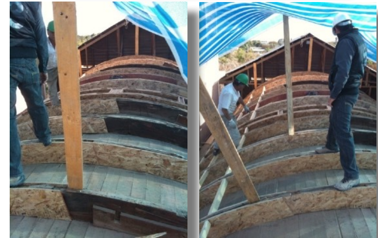
FOTOGRAFIAS REFORZAMIENTO EN COSTILLA CON OSB
