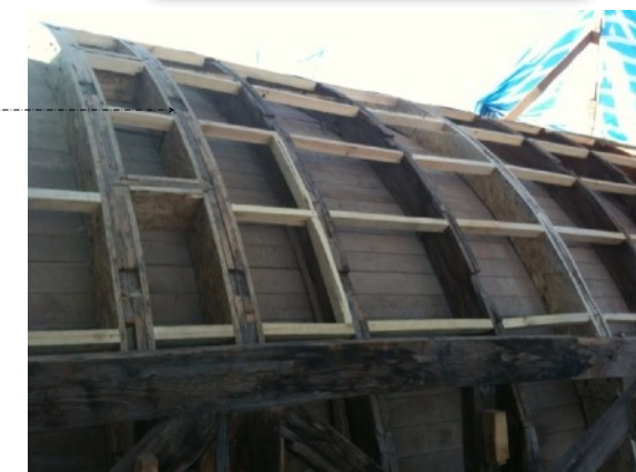
FOTOGRAFÍAS INCORPORACION DE COSTANERAS EN NAVE CENTRAL
