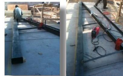
DETALLE DE CERCHA DOBLE METALICA
