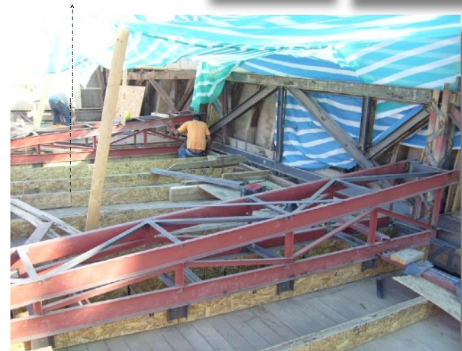
FOTOGRAFIA DE CERCHA METALICA CONSTRUIDA EN OBRA
